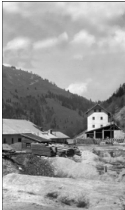
Betonwerk Gaisbichler, Ende April 1949
